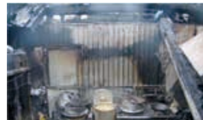
出火室の状況
