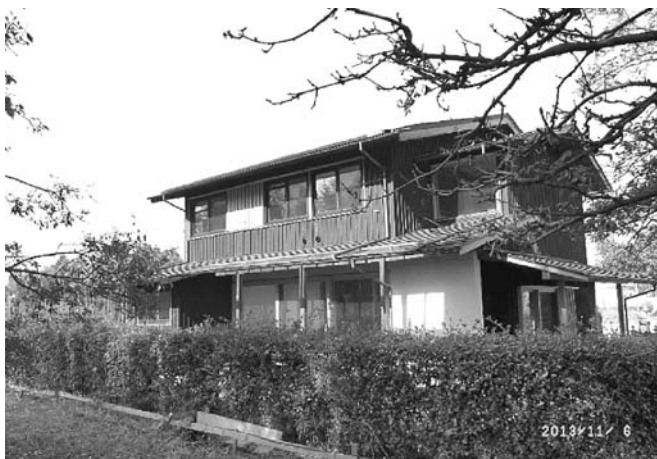
写真1 モデル木造住宅外観写真
