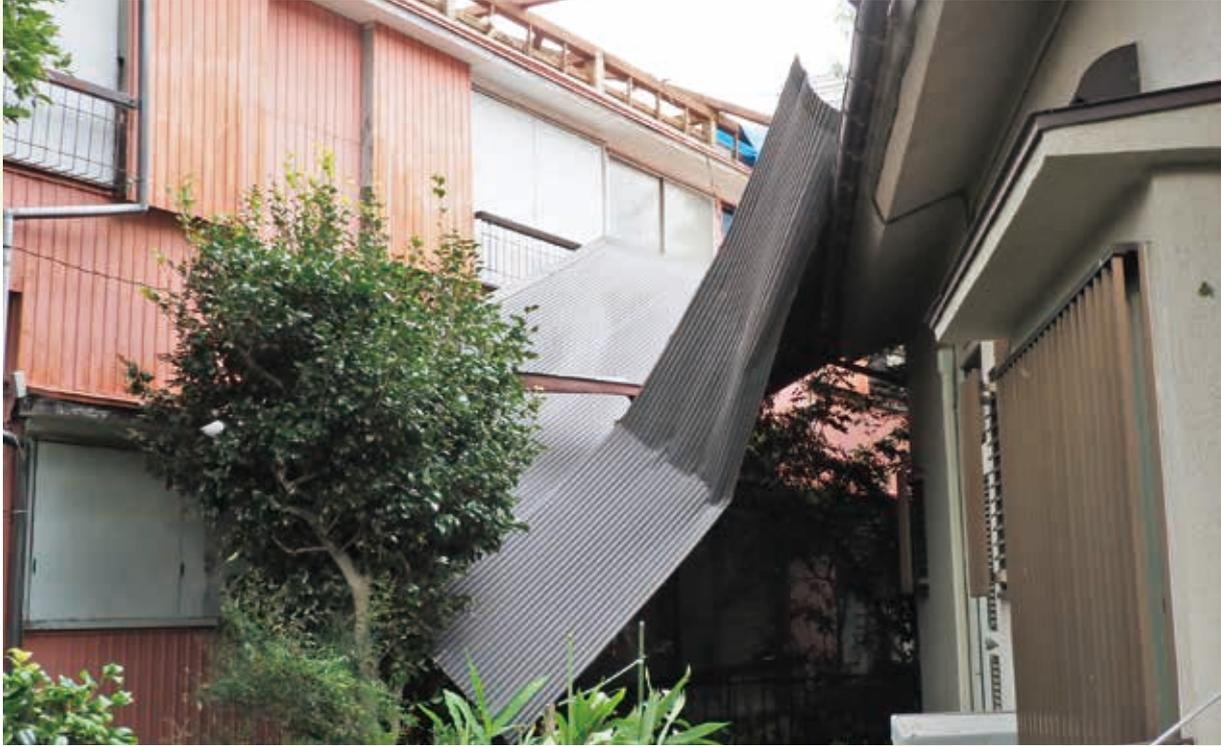
2019年9月の房総半島台風で屋根が飛ばされた横浜市内の住宅、風害のリスクが浮かび上がった
